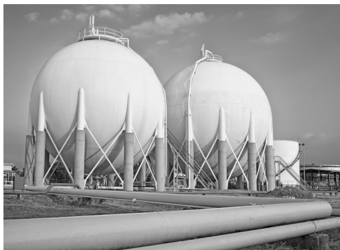
Reservatórios de combustível construído com chapas de aço.
